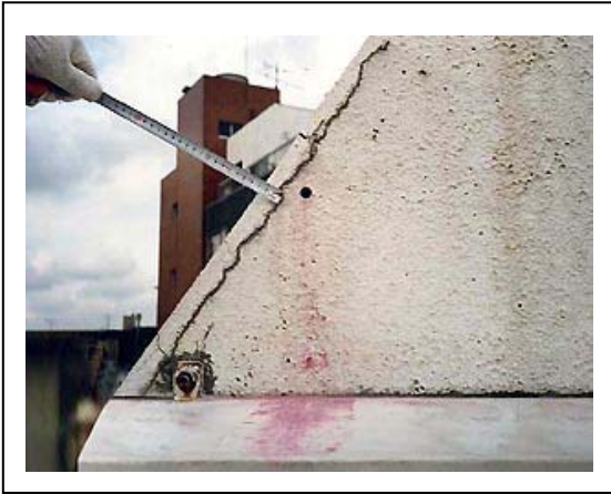
写真1 斜壁に太陽のふく射熱による繰返し伸縮や笠木下端からの雨水の浸入によりコンクリート塵体の剥離が起きている。放置すると落下事故につながるおそれがある。
