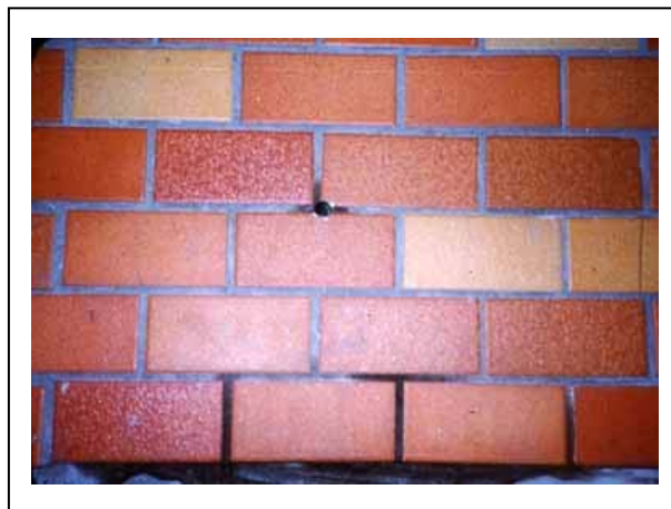
写真 6 仕上げタイルの下地モルタルの浮き、タイル背面ひび割れ補修使用およびエポキシ注入接着剤の適正粘度設計のため、外壁に 10mm の穴をあけた。
