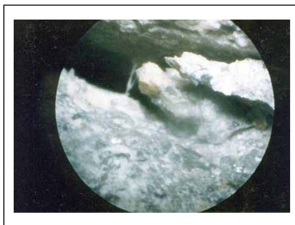
写真 8 改修工事の際は、高粘度のエポキシペンニング接着注入が必要である。
