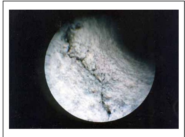
写真4 ひび割れ補修仕様およびエポキシ注入適正粘度設計のため、前方斜視野タイプの内視鏡により調査を行なった。
