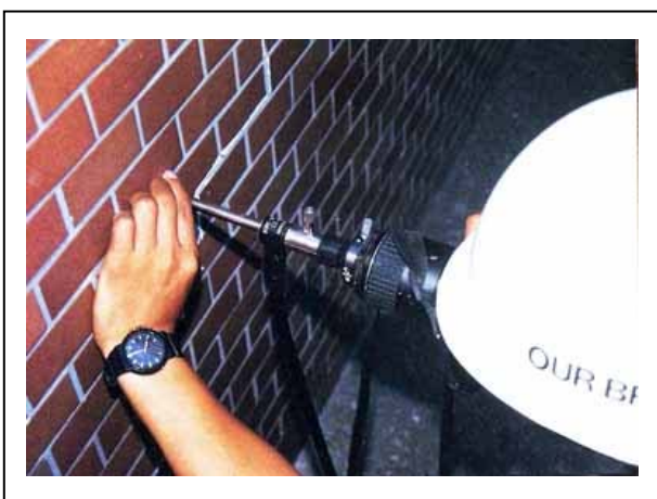
写真 7 内視鏡によるタイル浮部背面ひび割れ調査 タイル剥離は、躯体とタイル下地モルタル間において 3mm~6mm のひび割れ幅が生じていた。
