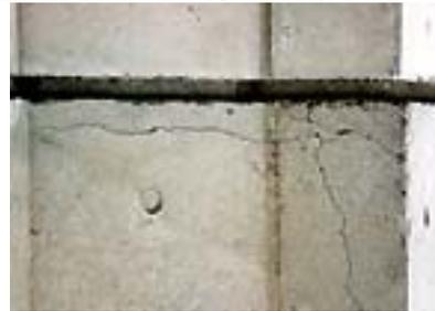
写真-3 マス目スケールによるひび割れのチェック
