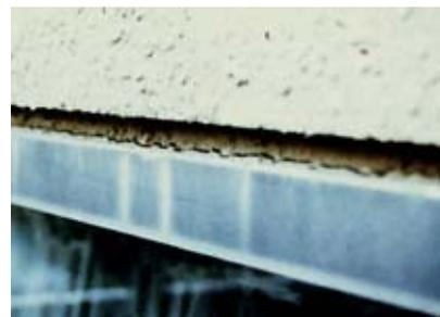
写真-15 手摺根元の錆・劣化
