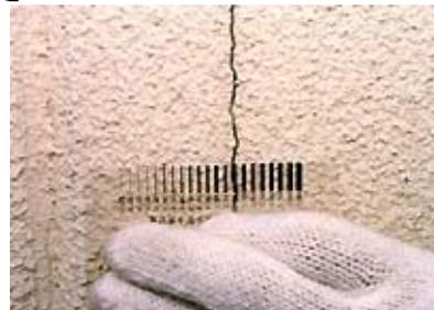
写真-5, 6, 7 パラペット廻りのひび割れおよびクラック
