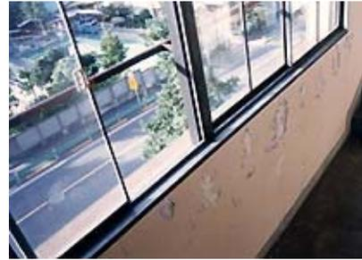
写真-13 鉄筋発錆による仕上材の剥落
