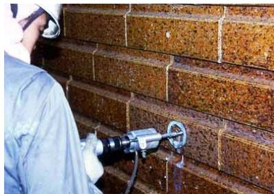
写真-3 ボーリングマシンによるコア抜き
