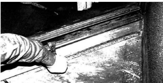
少ない段差の開口部で防水層を補修している例 FRP 塗膜防水などを施し、床面とサッシを一体化した水切りにするといい補修法がある。
