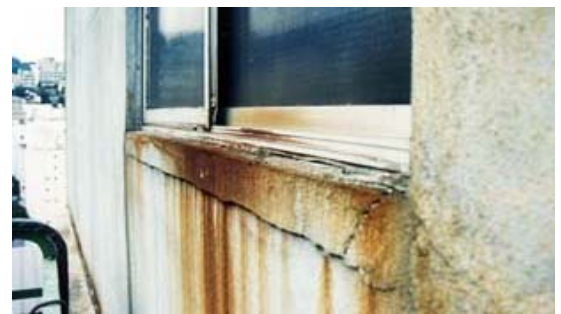
窓下の躯体がひび割れて水が浸入し、鉄筋がさびた例
