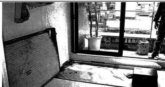
テラス側開口部から漏水した例 室内の床面まで濡れている。
