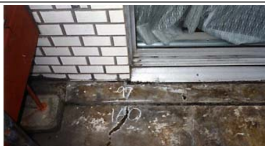
外部テラス面と室内フロアレベルの差が小さい例 防水層の立ち上がりが不足しているために漏水してしまう。
