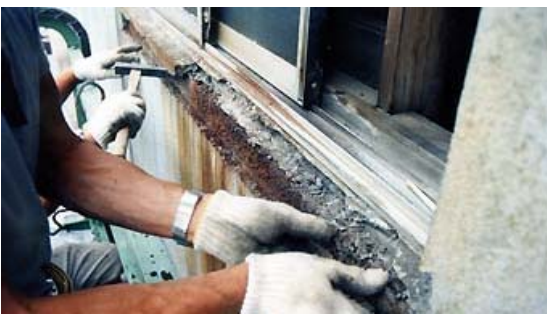
躯体の鉄筋がさびてポロボロになった様子 コンクリートがかたまりのまま、はがれ落ちてしまう危険がある。
