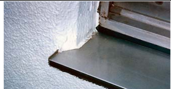
結露水やシーリング材による汚れ
