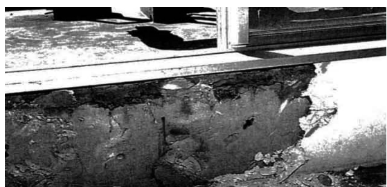
防水層の高さが足りなかったため、サッシのすき間から漏水した例 テラス面からの立ち上がりがあっても、防水層がきちんと上部にまでいっていないと漏水が起こる。
