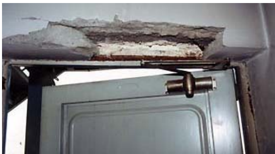
扉のスチール枠にたまった水によって鉄筋がさび、コンクリートがはく離した例 水抜き穴を確保するなどの対処が必要だ。
