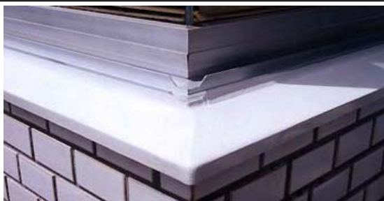
補修した窓台
