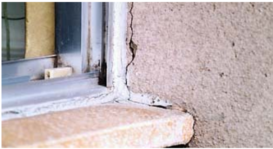
周囲のモルタルに亀裂が入った例 窓枠を取り付けた後、モルタルですき間を補修してしまうとひび割れの原因になりやすい。
