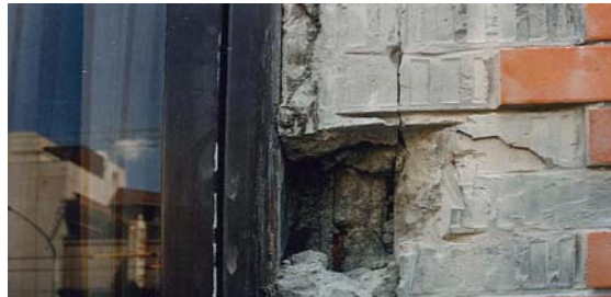
スチールサッシの周囲に起きた破損 スチールサッシの強度が高いため、振動の際に建物の揺れに追随せず、補修モルタルとの間に亀裂が入った。
