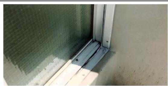
水切りとサッシの間に亀裂が入った例 水切りをサッシに差し込まず、その間をシーリングしていたため、材が切れてしまった。
