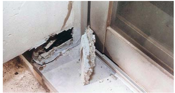
水切りの熱膨張で端部のモルタルを破損した例 膨張を吸収する箇所をあらかじめ用意しておく必要がある。
