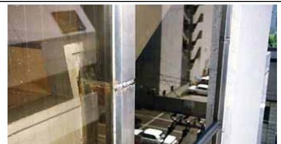
サッシ縦枠の継ぎ目が割れた例 枠同士の継ぎ目の処理も要注意だ。
