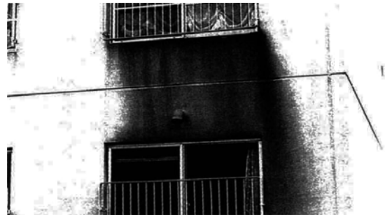
結露水やシーリング材による汚れ
