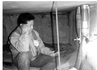
反転機、ラミネートチューブ内の空気圧を一定に保ったまま（既存排水管に内接してエポキシ樹脂管を形成するためには不可欠）約4時間の養生に入る。
