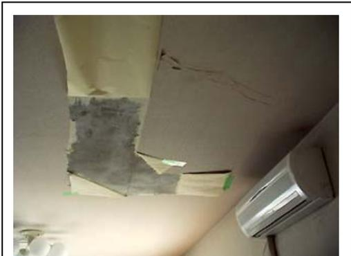
漏水個所のクロスを一部はがして調査したところ、コンクリートスラブにスリーブ穴の埋め戻し跡を発見した。
