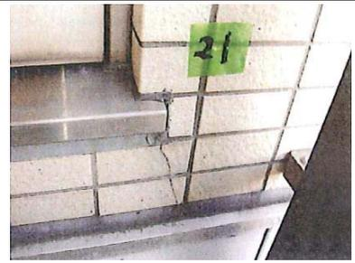
香料検知調査の結果、香料濃度が大きく上昇した個所が浸水口の可能性がある。ここでは、パイプスペースの扉の隅にできたひび割れが浸水口と思われる。
