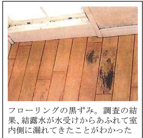
外部側の開放廊下はほとんど雨が吹き込まない形状ではあるが、まずは散水調査を行って、外部からの漏水の有無を調べることにした。調査に併せて、内装材の解体調査を行った。解体時のフローリングの状況を確認すると、フローリング背面にカビが付着しており、何かしらの水の影響を受けていることを確認した。
