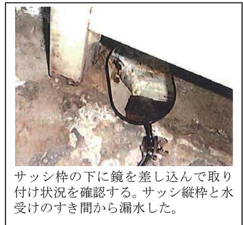
狭い部屋で換気をせずに就寝していたことが結露の原因のひとつであった。寝ている時も人間や動物は水分を放出する。特に冬場、閉めきった部屋で就寝すると、朝方温度が下がるため、室内の相対湿度が高まり、結露が発生しやすくなる。その結果、窓ガラスやサッシ枠に大量の結露水が発生し、これが流れ落ちて、水抜きのふさがった水受けにたまり、オーバーフローしてフローリングを変色させたのである。
