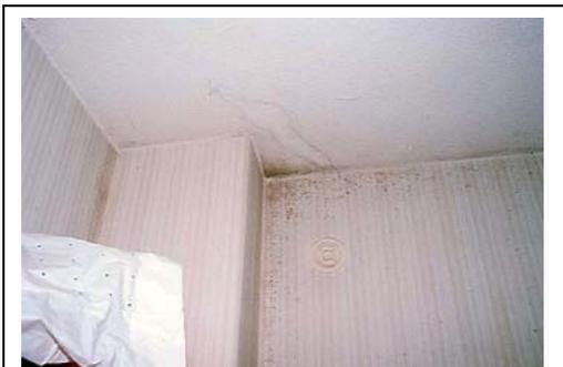
天井面に漏水している。仕上げは、コンクリートスラブに直接クロスを張った直天井だった。
