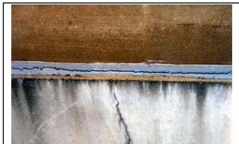
モルタル上端部に生じたひび割れ、防水層を壁に沿って立ち上げ、モルタルで押さえている。ここから雨水が浸入した。
