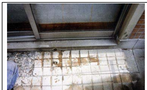
幅木上端部やモルタル面台はひび割れが生じやすく雨水が浸入しやすい。
