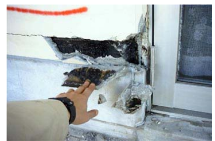
補修モルタルの裏まで防水層が立ち上がり、補修モルタルの肌分かれを助長している。
