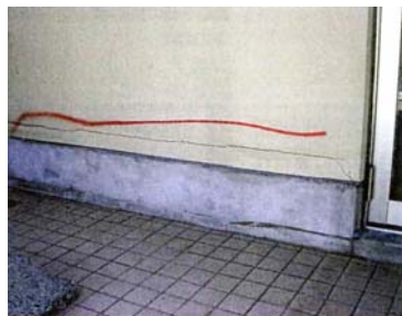
躯体と付け送りモルタルの取り合い部に亀裂が入る。補修モルタルが躯体と肌分かれしたために亀裂が生じた。
