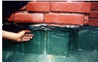
補修で雨漏りが悪化。タイル背面の雨水をウレタン防水層で受けていないからだ。床まわりの仕上げをはがすとタイル背面の雨水がしみ出た。
