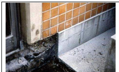
壁面下端の押さえモルタルと床の仕上げを撤去すると防水層が現れた。防水層が幅木の途中までしか無く、雨水が裏側にまわりやすくなっていた。
