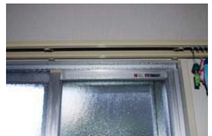
写真17 サッシ・ガラスに生じた 結露
