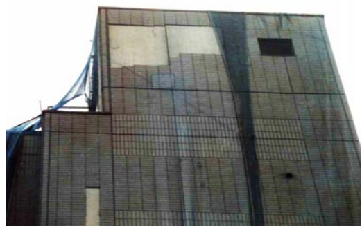
写真4 外装タイルの剥落
