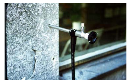
写真12 コンクリート内部の検査
