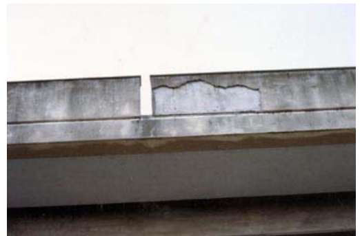
写真3 パラペット仕上げモルタルの剥落
