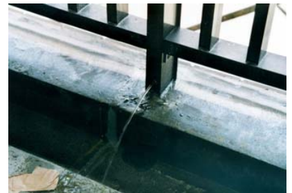
写真16 手すり支柱固定部が破損 した例
