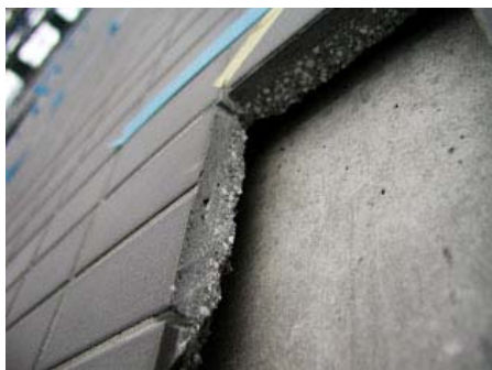
写真5 タイル下地の浮き
