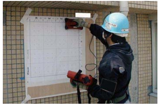
写真1 鉄筋探知機による埋設鉄筋の調査
