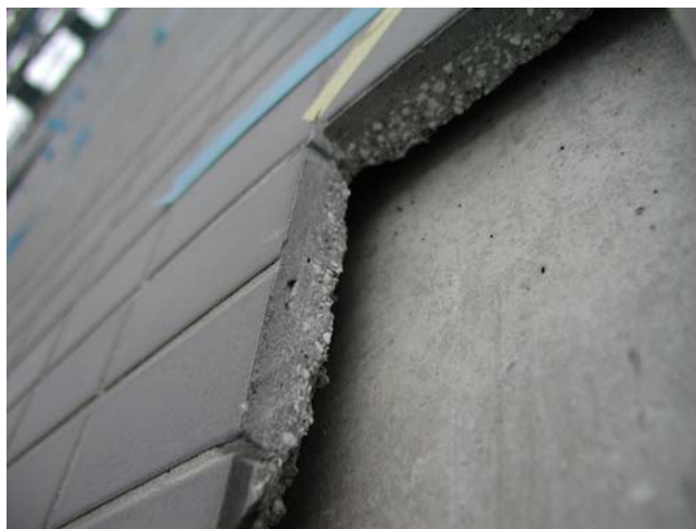
4.5.1 コンクリート下地と張付モルタルの間の浮き
