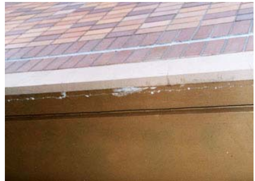
4.1.2 漏水を伴ったひび割れ (軒天鼻先)
