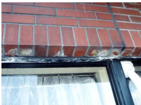
写真4.2.3 開口部上部タイル壁の背面 に雨水の浸入
