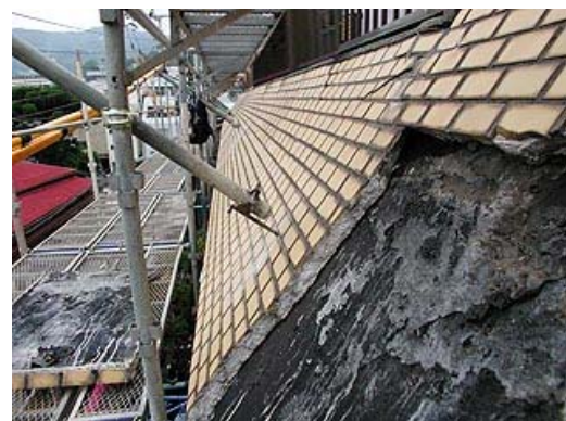
4.1.4 防水層を施している斜壁の剥離
