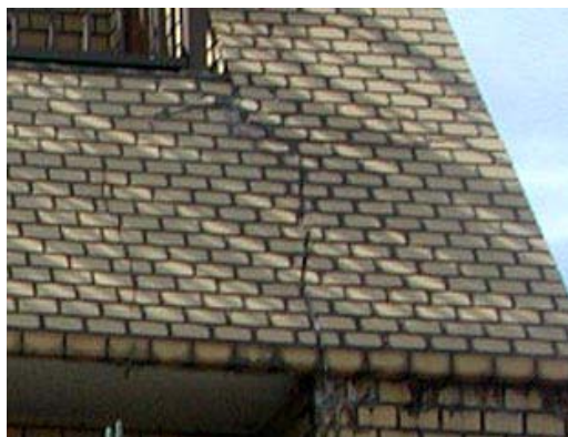
4.1.3 斜壁に生じたひび割れ
