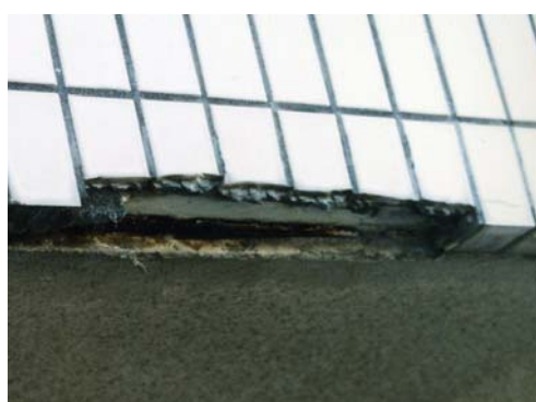
4.2.2 上部の錆びた鉄筋
