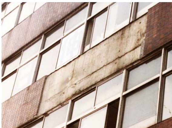
6.6.1 厚づけタイル下地層ごと剥離した例
